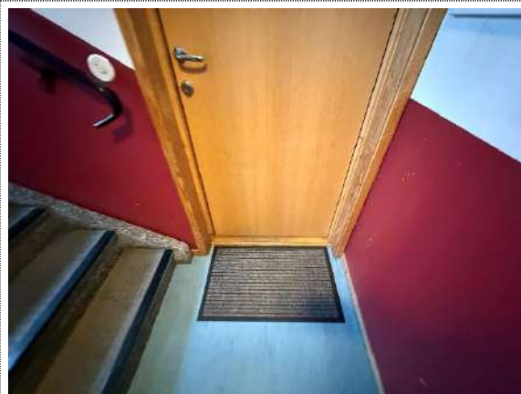
Bilde til tiltak 24.2 Utskifting av samtlige innvendige leilighetsdører og ståldører i blokkene.
