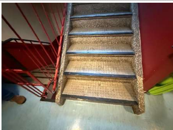
Bilde til tiltak 28.1 Utskifting av belegg i trappetrinn med trappenese, belegg på reposer og i etasjene oppover i trapperommet.
