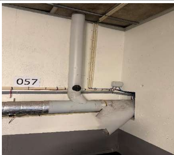
Bilde til tiltak 31.2 Reparasjon av isolering og mantel.
