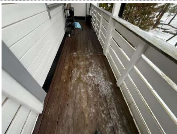
Bilde til tiltak 28.2 Normalt vedlikehold av overflater på svalganger og balkonger med ny overflatebehandling.
