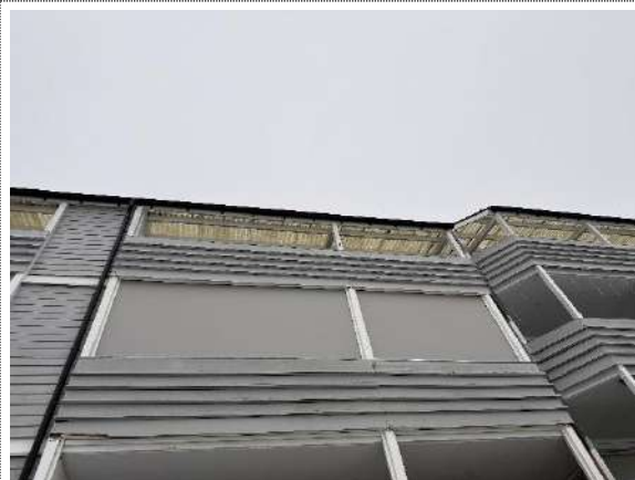
Bilde til tiltak 28.3 Utskifting av råteskadet og slitt trevirke i rekkverk på balkonger for blokkene.
