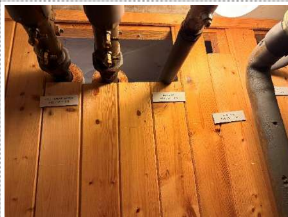
Bilde til tiltak 32.2 Ender med løs isolasjon påsettes forblending.
