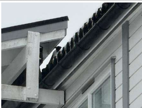
Tiltak 26.1 Utskifting av takstein på rekkehus og øvrige bygninger med denne tekkingen.
