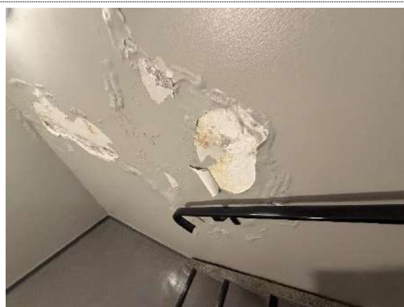
Bilde til tiltak 21.1 Utbedre drenering med grunnmursplast ved Dyretråkket 31.
