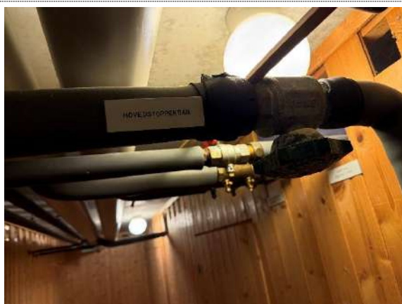
Bilde til tiltak 31.3 Eksempel på merket hovedstoppekran, dette gjennomføres på alle hovedstoppekraner.
