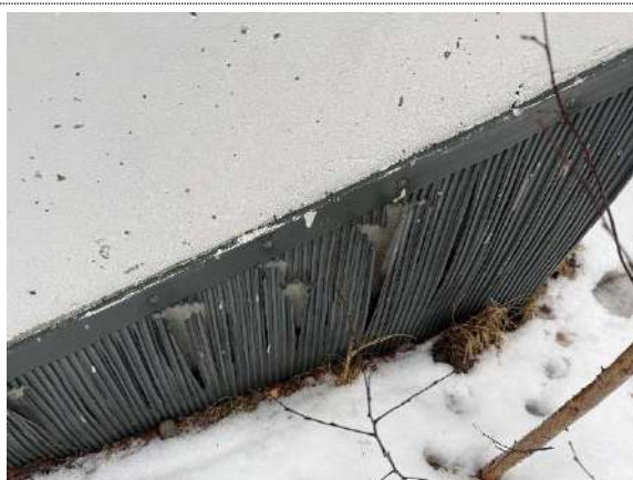
Bilde til tiltak 21.2 Utbedring av grunnmursplast som står ubeskyttet mot klima og mekaniske påkjenninger.
