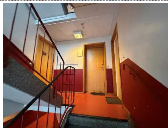
Bilde til tiltak 24.1 Overflatebehandling av trapperom, inkludert gulv og himlinger.
