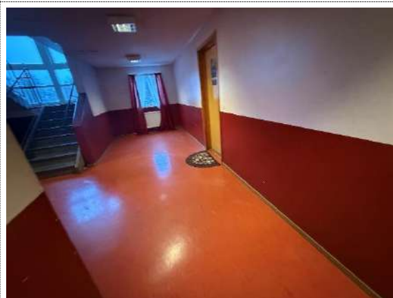
Bilde til tiltak 25.1 Beleggene anbefales skiftet ut med nytt.
